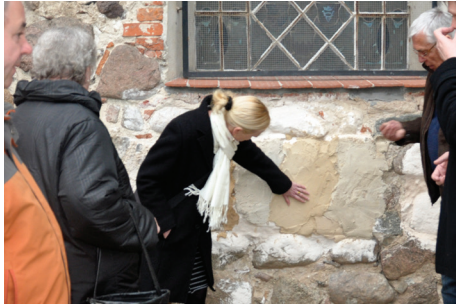
Verantwortung teilen: Ortsälteste bei der Baubegehung
